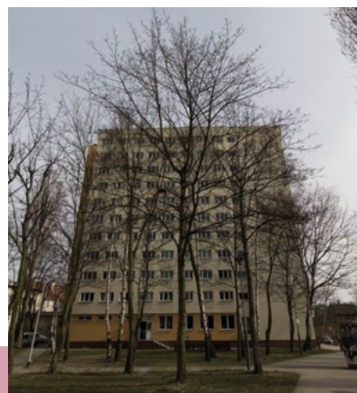
▲ W 1969 roku oddano 11-kondygnacyjny wieżowiec w osiedlu akademików Politechniki Gdańskiej przy ul. Stanisława Wyspiańskiego (fot. Jarosław Wasielewski)
